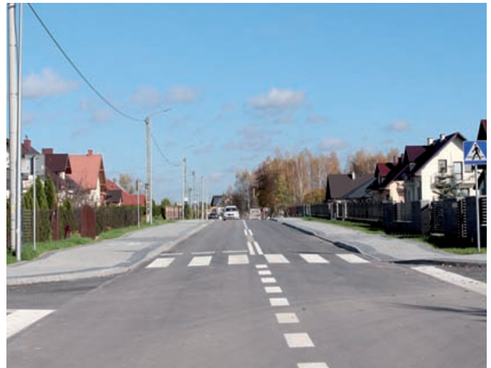
Gorzyce - osiedle, nowa droga 1KDL.
